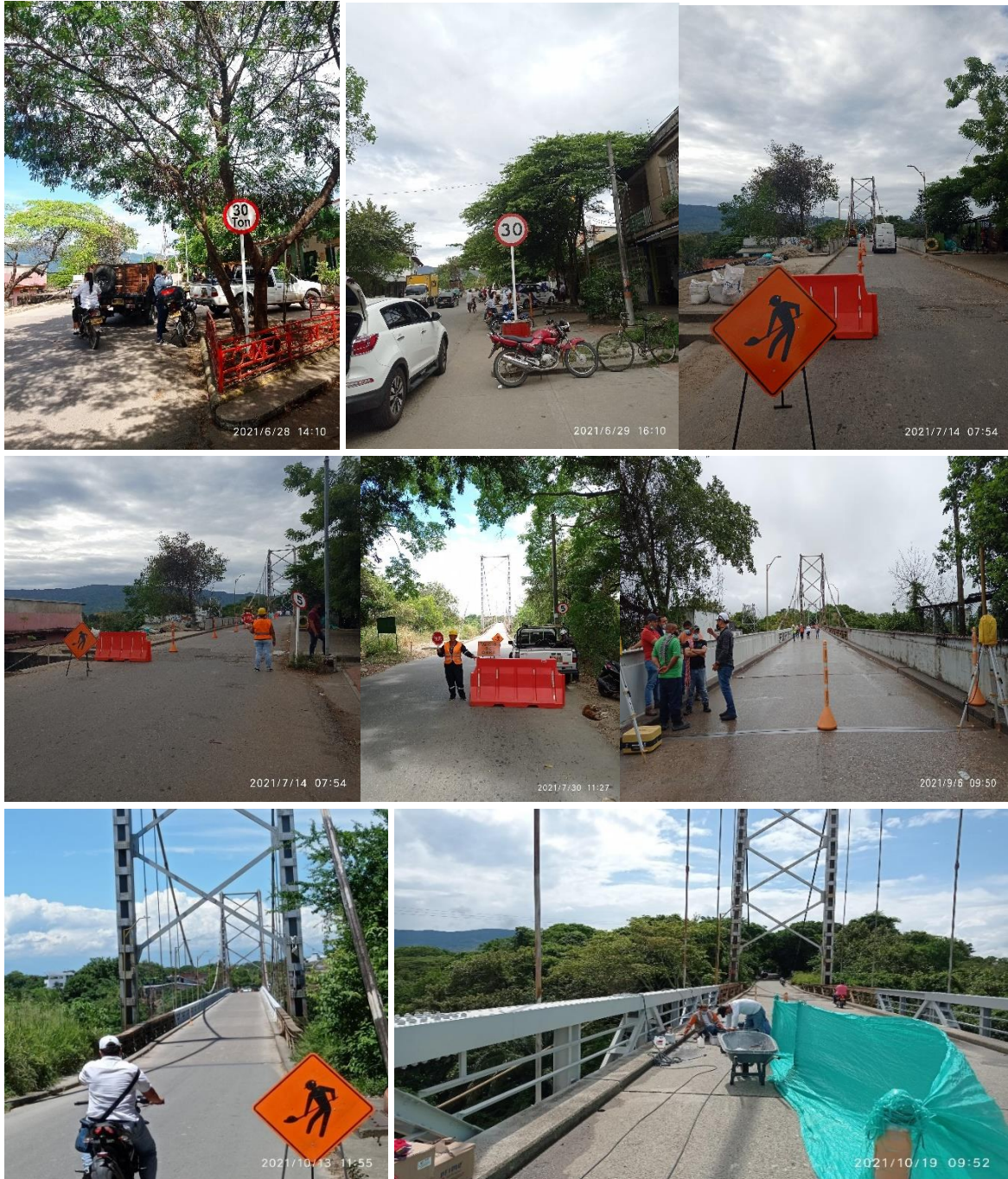
Imagen 11. Señalización instalada diariamente para ejecución de trabajos sobre el puente. Fuente: Propia
