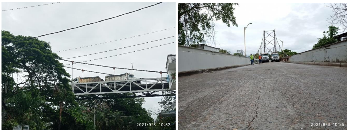
Imagen 13. Fotografías de implementación de prueba de carga.
